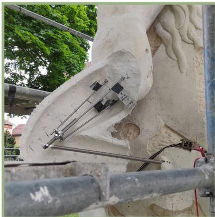
Après scellement des nouveaux pieds, des moules avec membrane souple et chape rigide sont fabriqués, sur place et en atelier, puis positionnés sur la statue. L'étape de coulage du mortier Altar pierre peut ainsi débuter. Celui de la jambe droite s'effectue le 14 mai.
